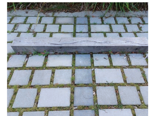
stationnements en pavés drainants
