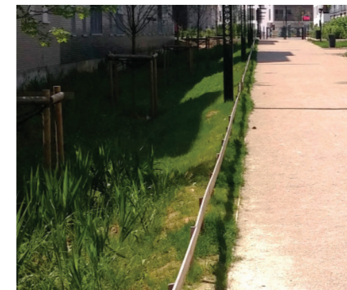
Noue accompagnant les cheminements
