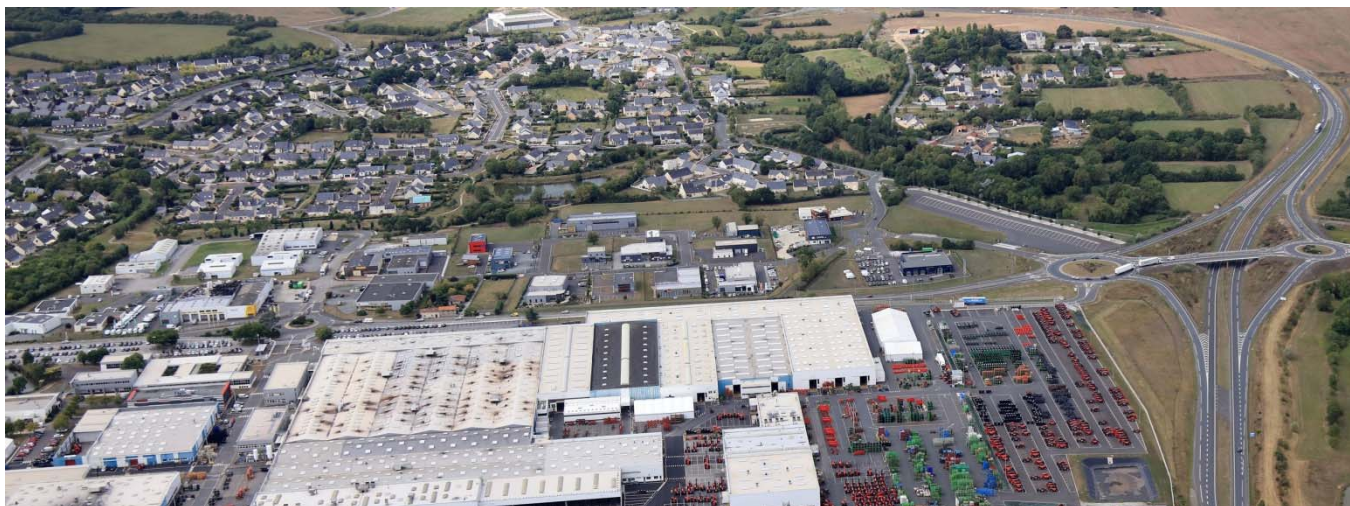
Le parc d'activités de la Fouquetière qui s'étire du sud au nord le long de la rue de l'Aubinière (le siège de Manitou au 1er plan)
