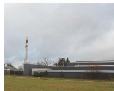
5 bâtiment de la tolerie au nord de la parcelle EM2
