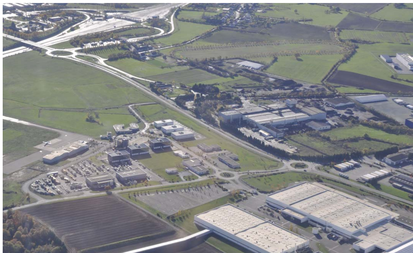
L'Aéroport et la RD 923- photo : Archidée - novembre 2010
