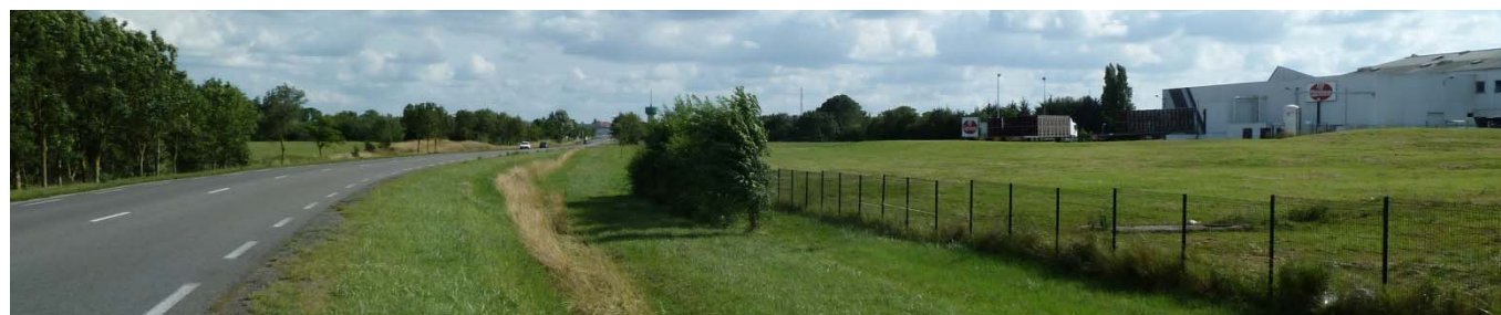
9 - La RD 723 (rocade Est): Le château d'eau proche de l'hôpital en point de mire
