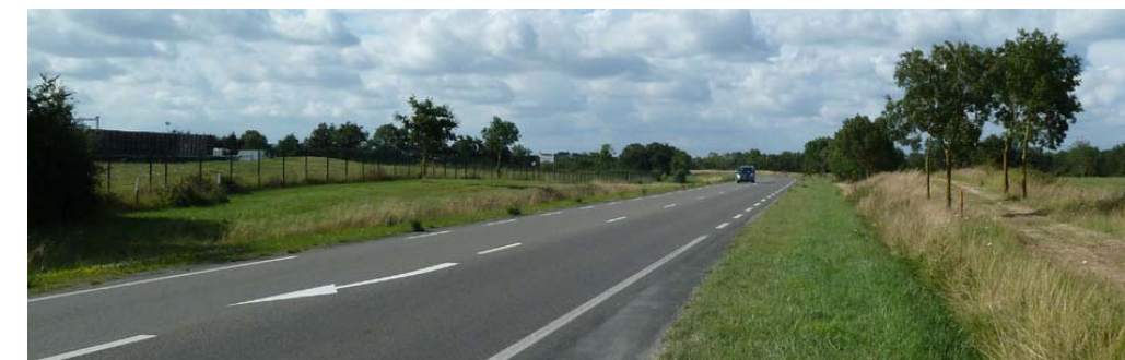
La RD 723 (rocade Est) vers l'Aubinière au niveau du boulevard Jules Verne
