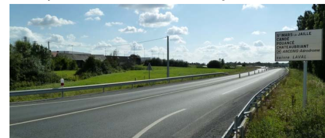
2 - La RD 723 (rocade Est) à l'approche de l'échangeur de l'Aubinière
