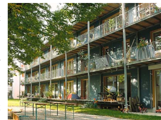
bâtiment passif – façade sud
