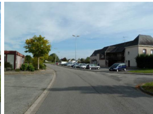
Rue des Jeux Olympiques
