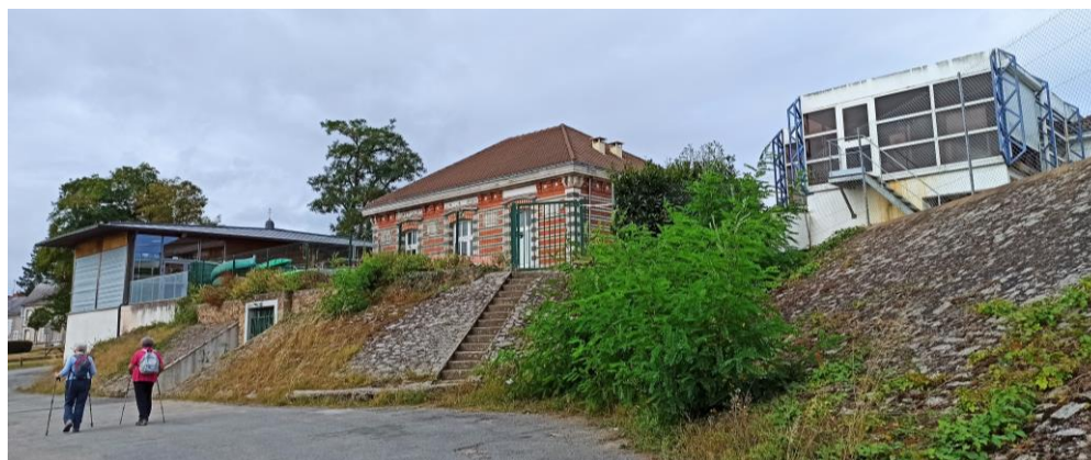
Déplacement de l'usine d'eau
