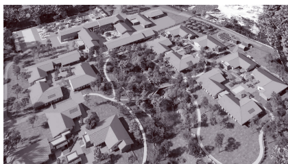
Vue aérienne du Village Landais Alzheimer, © Département des Landes, 2020 L'établissement laisse une grande place aux espaces extérieurs ouverts sur la ville
