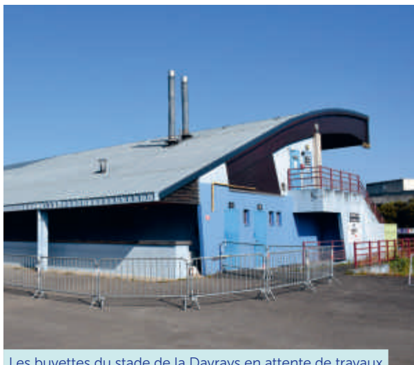
Les buvettes du stade de la Davrays en attente de travaux
