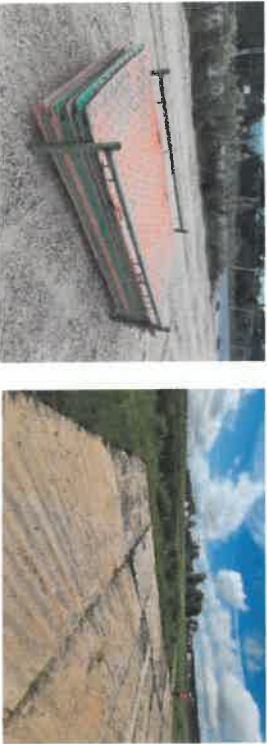
Exemple de plaques permettant la portance des engins sur sol meuble/humide (© THEMA Environnement)
