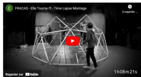
Time-Lapse du montage du dôme géodésique https://youtu.be/PzVy3AW78-w
